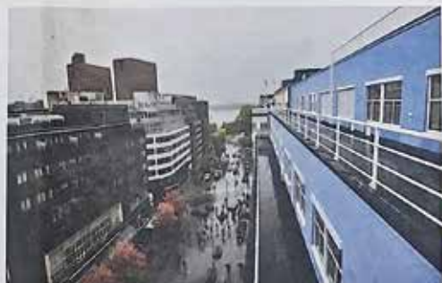
Herri Odeon i luften ser du en ny linje som viser hvor stramt og elegant funksjonalismen kan være. Den er ryllig fra bakkeplan også. Foto: Jan S. Kjøpstad
