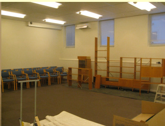
Teppelegging i øvingslokale.
