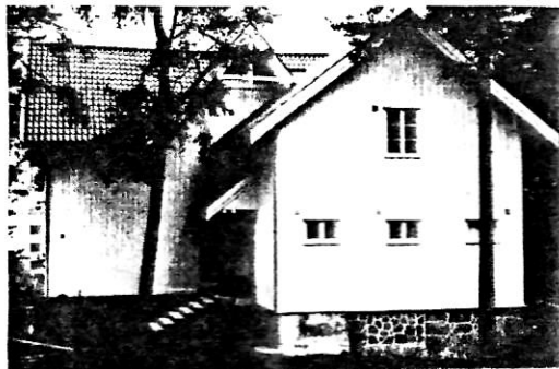
SETT FRA STINTAVEIEN
