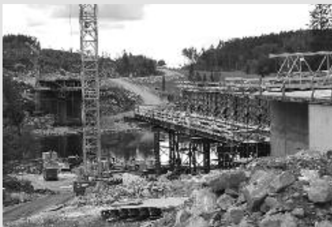
Brukarene på begge sider av elven er klare og tårnet skal støpes. Våre to «guider» fra Veivesenet informerte godt.
