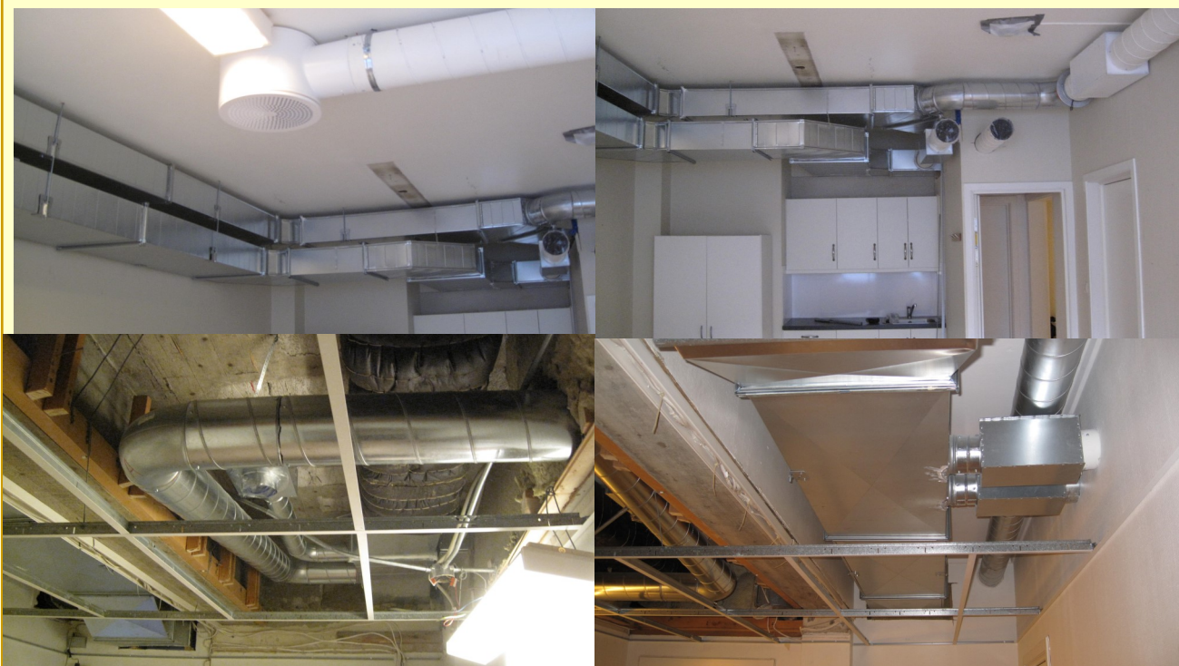
Det rives og bygges opp på nytt i 1. etasje
