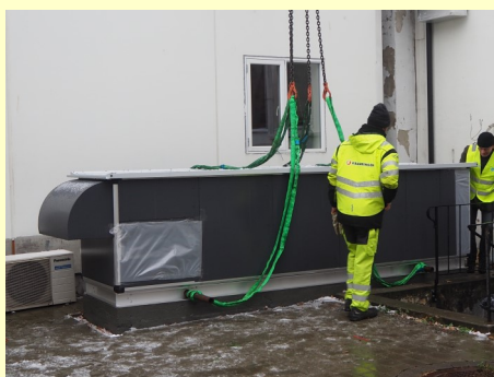
Ventila-sjonsaggregatet på 800 kg. løftes på plass i bakgården
