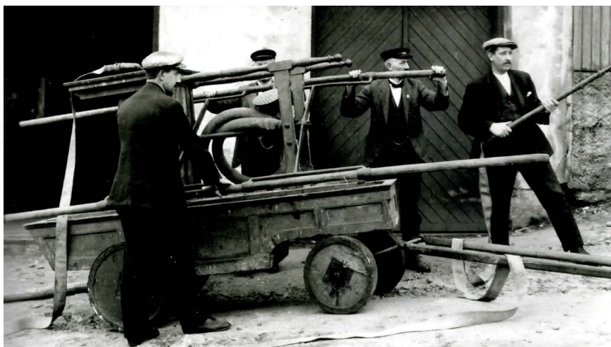
Manuell pumpestasjon. Andreas lengst til høyre i bilde.
