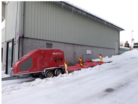
Tining av tele før graving
