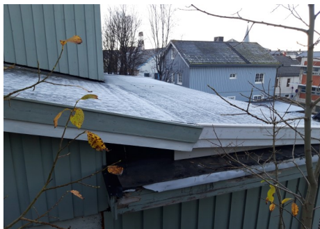
Nytt tak holder forhåpentligvis vannet
