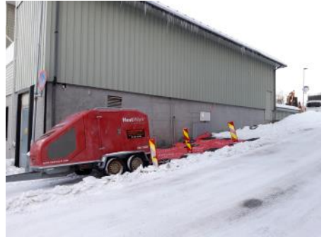
Tining av tele før graving
