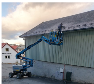
Bror Rista Dasic tar seg av arbeidet i høyden
