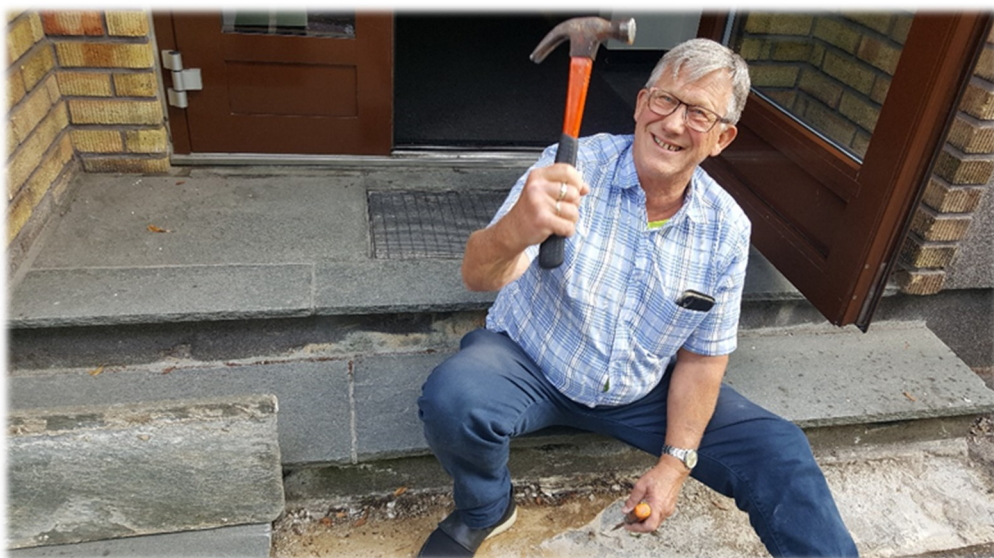
Inngangspartiet må også fikses. Satslaatten er god med hammeren.
