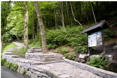
Stoltzkleiven etter opprustningen i 2011. Fortsettelse neste side.....
