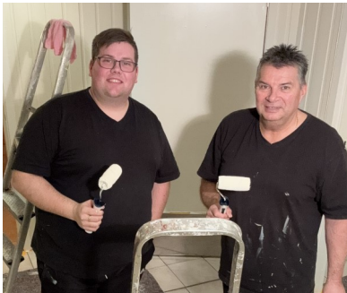
Garderobe og ytter- gang pusset opp.
