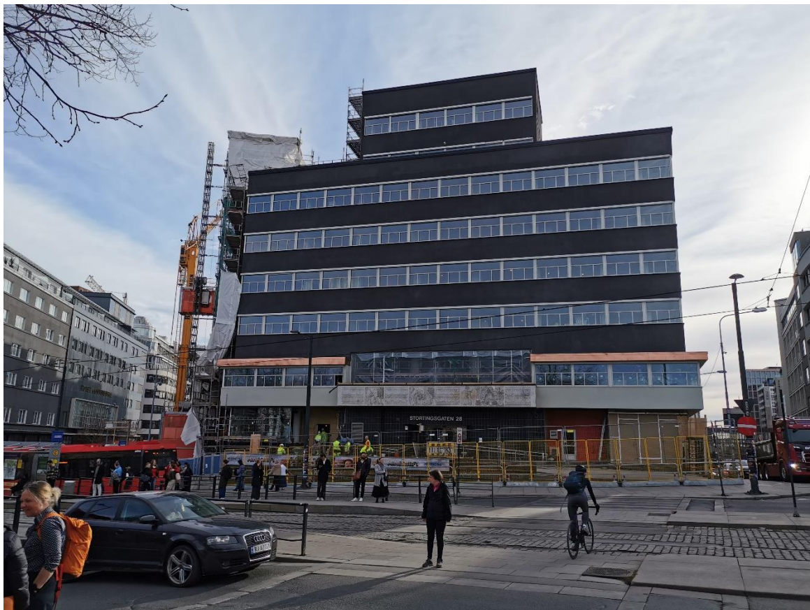
Foto: Simen Levinsky. Det nærmer seg. Huset er snart pakket ut av presenningene sine.
