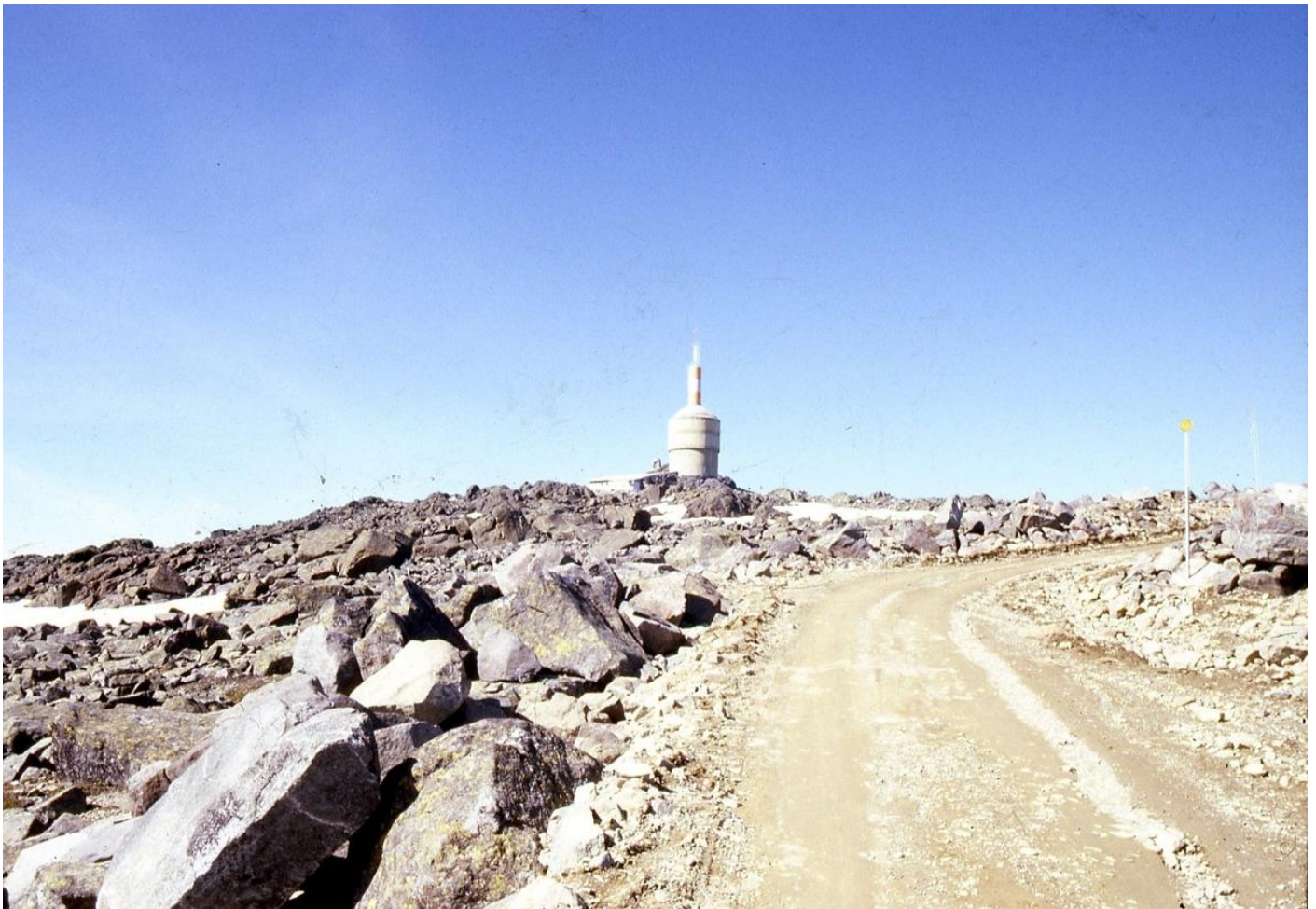
Radiolinjestasjonen på toppen av Tron
